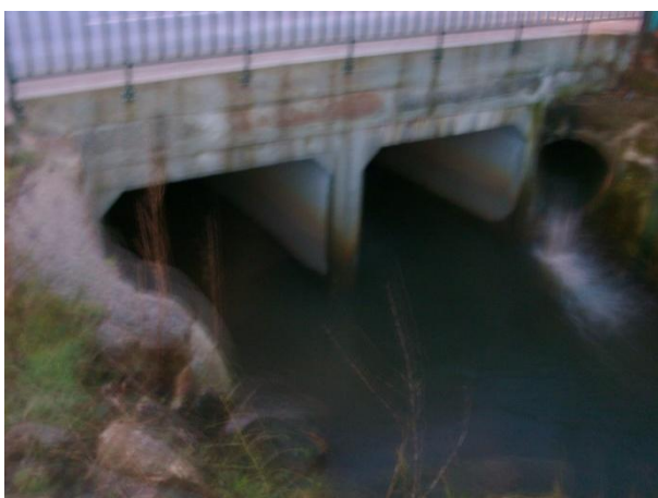
Fotografia 3 - Rio Jogo: passagem hidráulica sob a EM 513-4, com uma secção de vazão de 2 x (2.5 x 2.5 m 2 )
