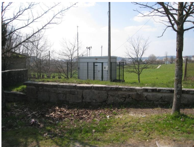
Fotografia 34 - Estação de monitorização da qualidade do ar na Av. Dos Templários, Paços de Ferreira
